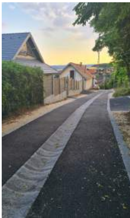
Bor utca felújítása
