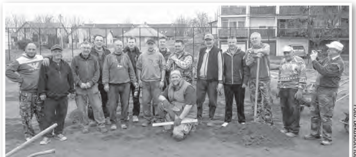
Helyi teniszbarátok is részt vettek a pályaépítésben
