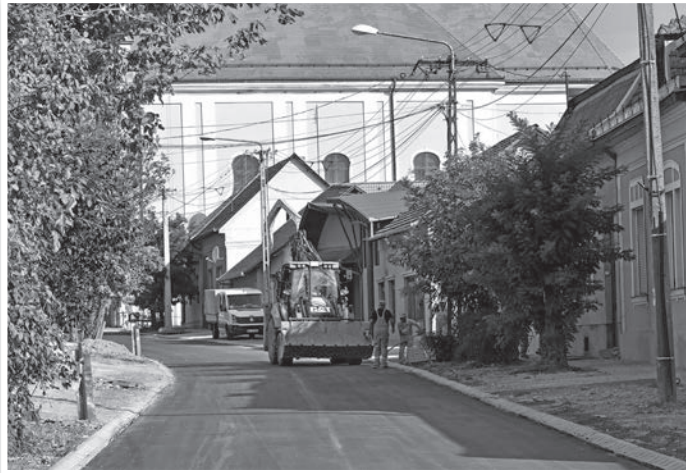
Gőzerővel zajlik a Kossuth utcai út- és járdaépítés is
