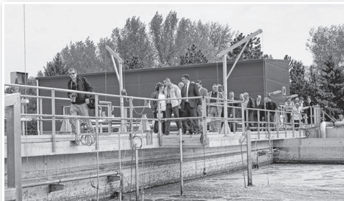
A szennyvíztelep rekonstrukciója 2014 szeptemberében készült el
