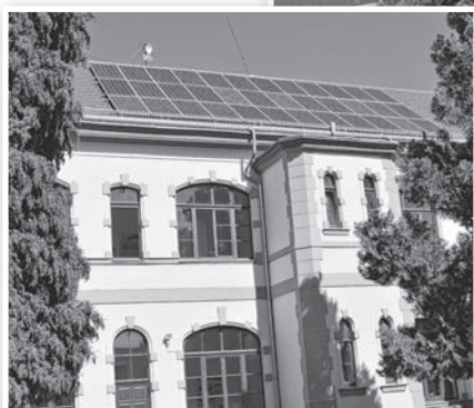
Napelemek a városháza épületén
