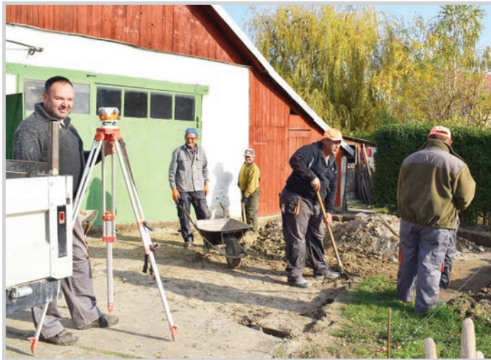
Péter Zoltán (a szintezőműszernél) és munkatársai egy építkezésen
