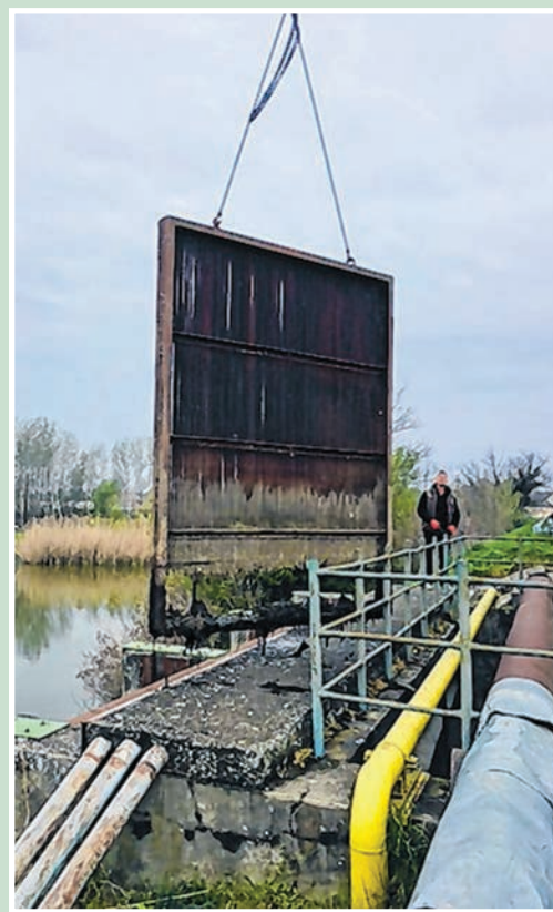
Felújították az elrozsdásodott halrácsokat is
