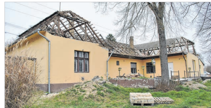
Megkezdődött az egykori Gödör presszó épületének bontása. Helyén panzió épül
