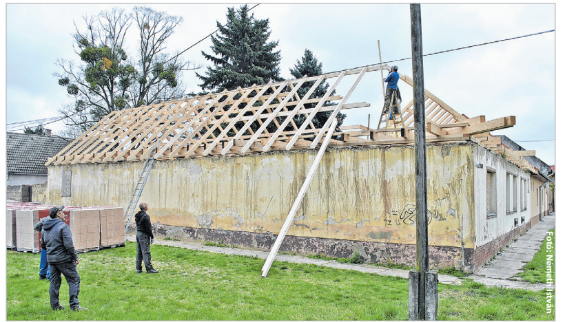
Megújulóban az egykori óvodaépület, a kép bal oldalán sapkában az egykori óvodás
