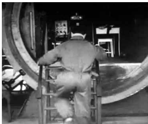
15. ábra. A pilóták vizsgálatát és edzését egy nagyméretű barokamrában végezték
