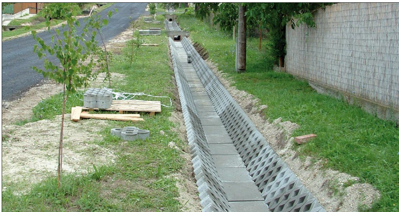
ÖREGHEGY: A KIÉPÍTETT KONTÉNERTÁROLÓ ÉS A TERÜLET TAKARÍTÁS ELŐTT KÉSZÜL A VÍZELVEZETŐ-ÁROK
