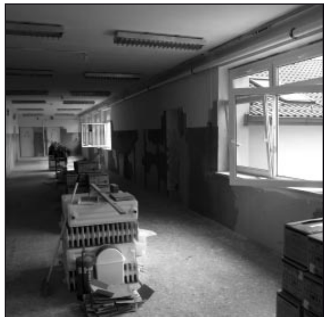
A folyosók gipszkarton burkolatot kaptak
