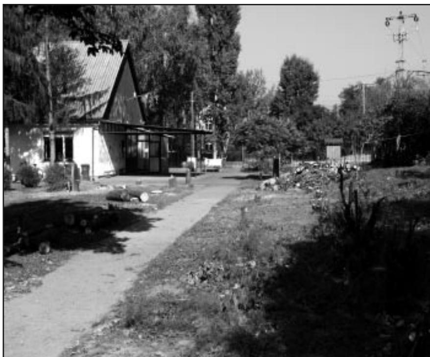
A terület előkészítésével megkezdődött az óvoda bővítése
