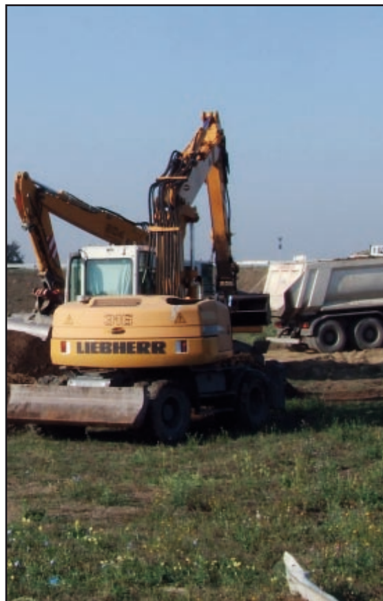
Megkezdődött a teljes értékű M7-es csomópont építése 4. OLDAL
