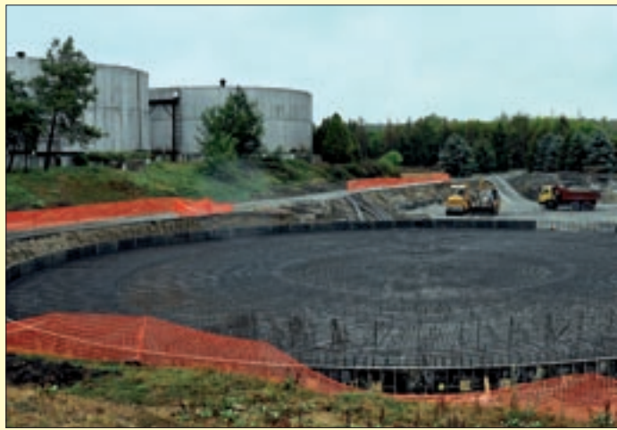
A szennyvíztisztító telep épülő új tisztítómedencéje
