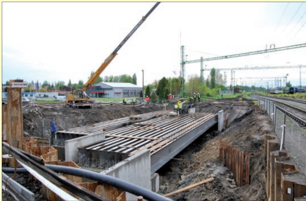
Jó ütemben halad az aluljáró építése
