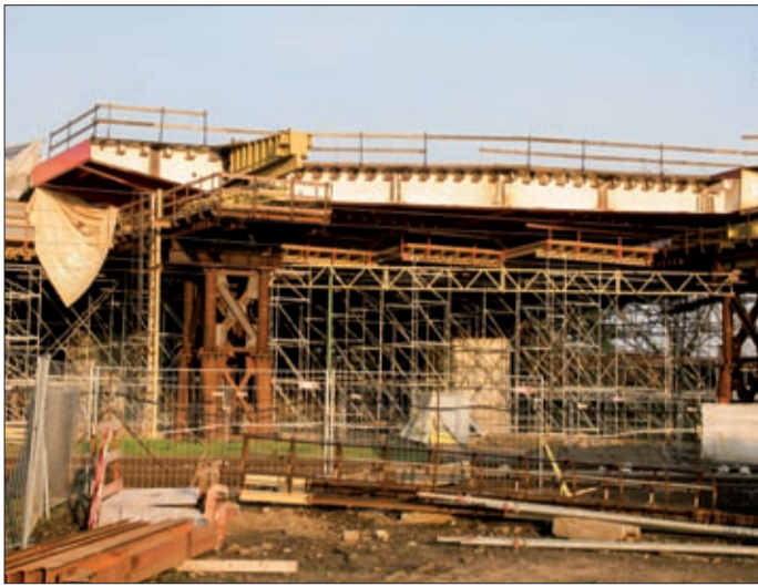
Épül az új, 2 x 2 sávós jaminai híd
