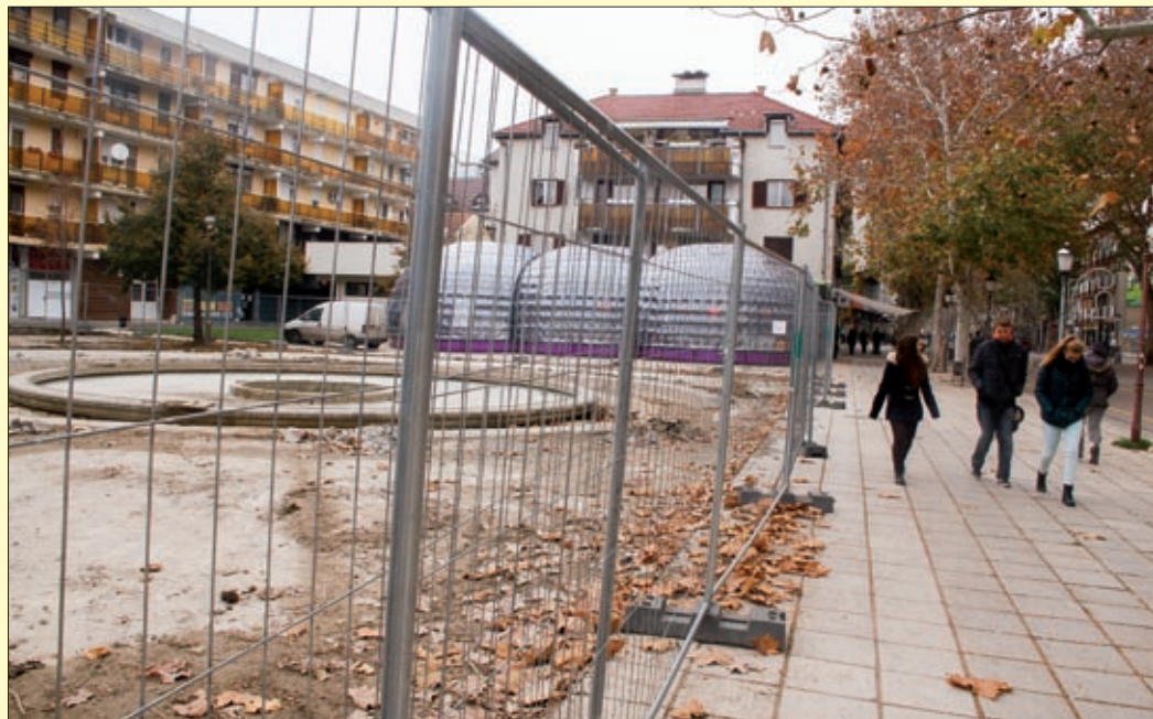
A felújítási munkák ellenére zavartalan a közlekedés a Korzó téren és környékén
