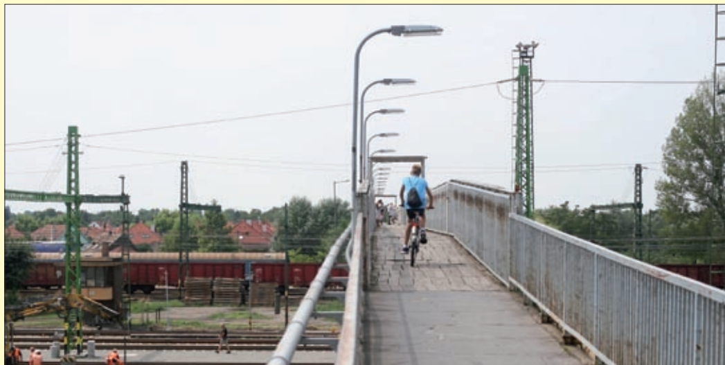
A híd járófelületének szélességét 2,6 méteresre növelik
