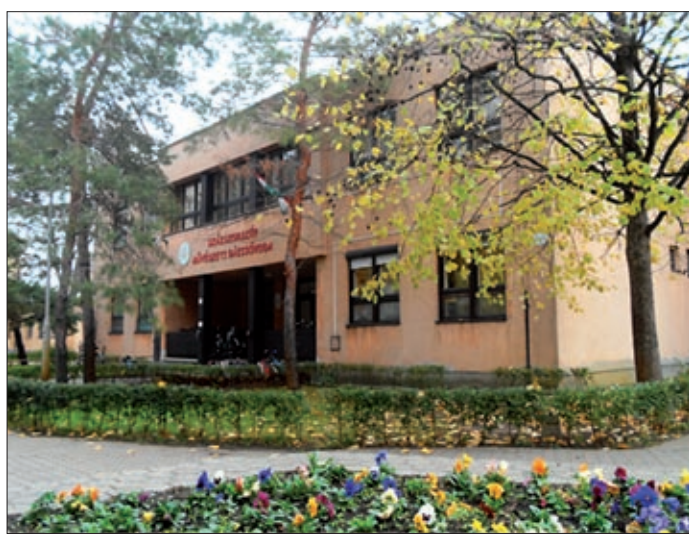
Három óvodát újítanak fel a közeljövőben
