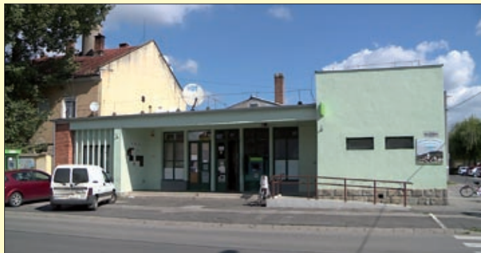
Az egészségház épülete már megérett a felújításra
