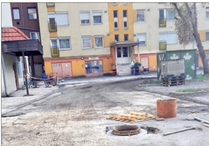
Az Andrássy út 16–18. belső udvarának felújítása
