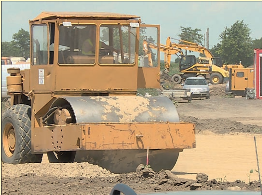
Négy külön szintű csomópont, 49 híd, 4 vadátjáró és 5 ökológiai átjáró épül
