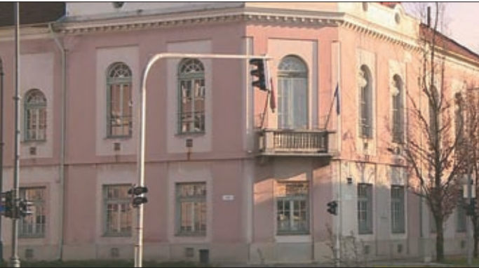
A Balassi energetikai korszerűsítése is megvalósul
