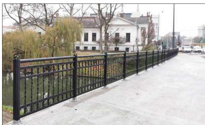
Korhű hidkorlátot kapott a Munkácsy-híd
