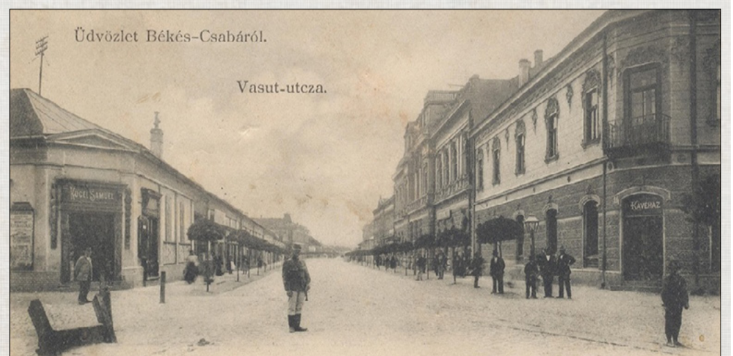
Üdvözlét Békés-Csabáról, Vasút-utca, 1906. A képen jól látszik az úttest két oldalát szegélyező, szilárd burkolatú járda (Tuska János gyűjteményéből)
