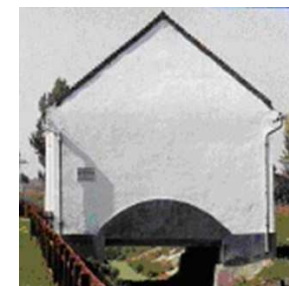
Vízi vágóhíd épülete
