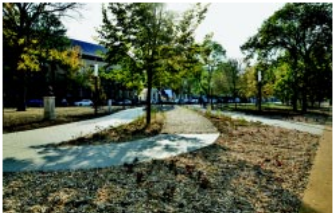
A Bessenyei tér felújításának része a nagyarányú zöldfelületi rekonstrukció mellett a nem csak iskolások körében közkedvelt futórekortán is
