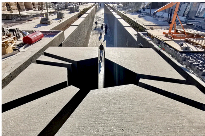
A széthasított gránittömb felülnézetből, az építkezés alatt. Fotó: Wachsler Tamás
