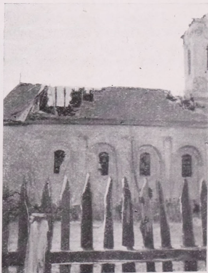
7. kép. A leesett sisak által bezúzott templomfedél.
