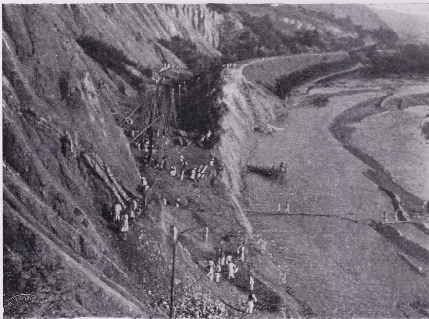
A mehádiai fekete-lejtőnél elpusztult magyar államvasuti töltés. Cena N. cs. és kir. altábornagy úr felvétele.
