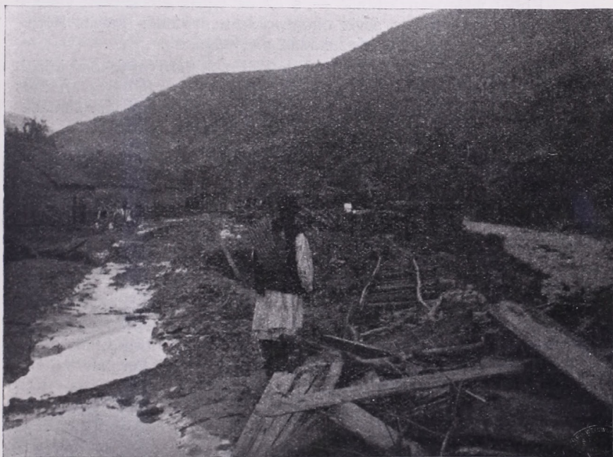
A vasúti töltés állapota az árvíz után a fenti híd és az állomás között. Cena N. cs. és kir. altábornagy úr felvétele.
