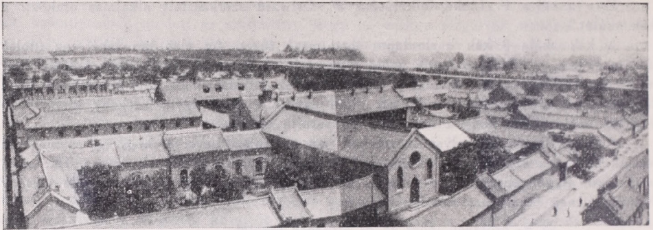
1. ábra. A tamingi missziós központ épületeinek távlati képe.
