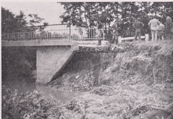
5. kép. Az 1957. július 14-i felhőszakadás pusztítása: a lezúduló víz hátulról elmosta a Nagytarcsa—Isaszeg közötti híd lábazatát.
