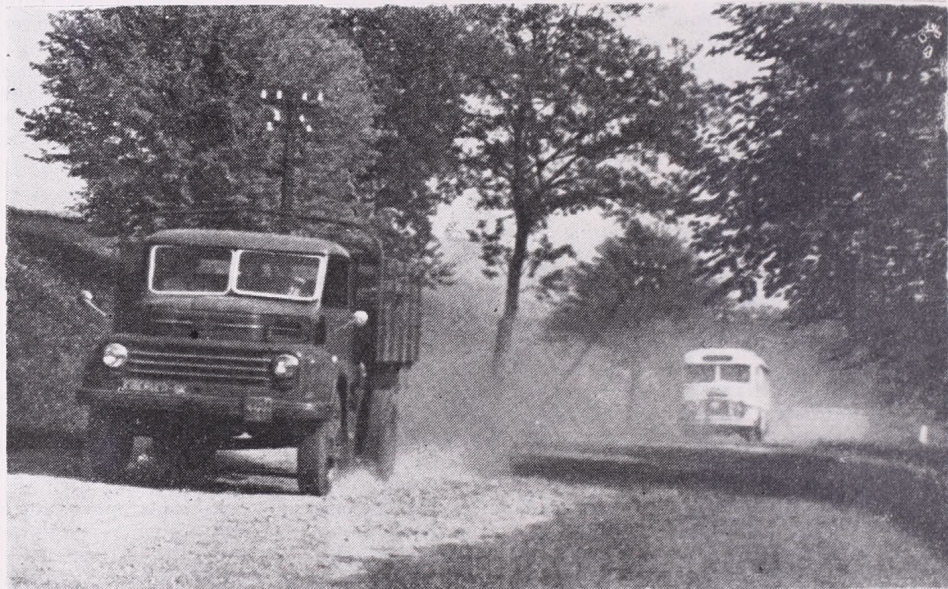
1. ábra. Az utak porvizsgálata; elől halad a „Csepel D—450” tehergépkocsi, amelyet követ a mérőműszerekkel felszerelt kocsi
