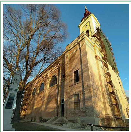
Adománygyűjtés a Római Katolikus Templom felújítási munkálataihoz (A képet Csuka Lászlóné készítette)
