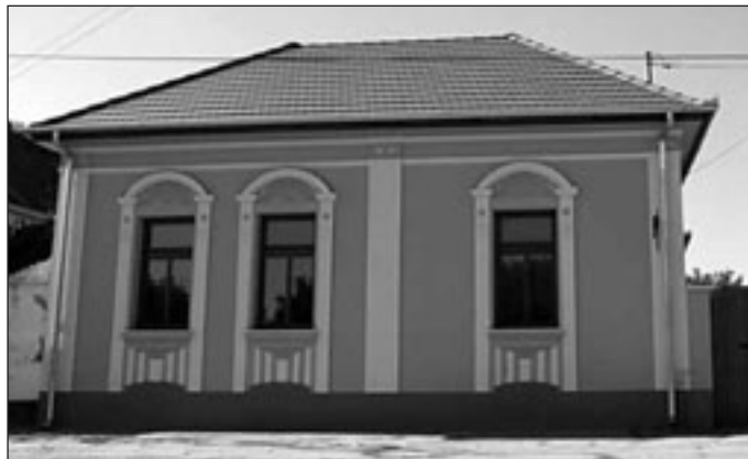
A felújított épület utcai homlokzata
