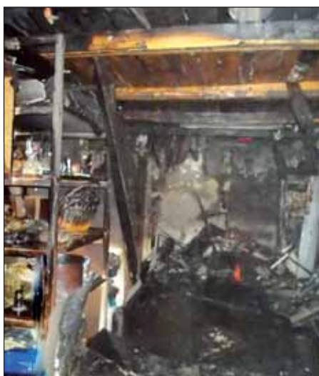
Fotó: Nagykőrös ÖTP
