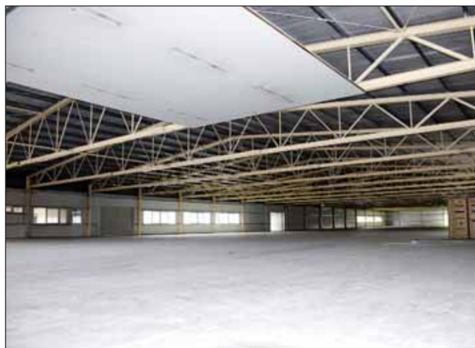
Jól halad az új csarnokkomplexum építése, melybe a meglévő vállalkozások költöznek be
