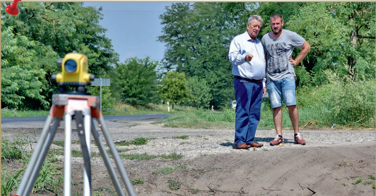
Az első kapavágások – elindult a kerékpárút építése a Gál kastélyig
