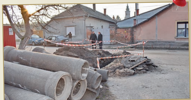
A Hétvezér utcában folytatódott a csapadékvíz-elvezető hálózat fejlesztése
