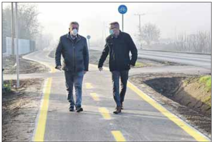
Cegléd felé tovább folytatódik a kerékpárút építése
