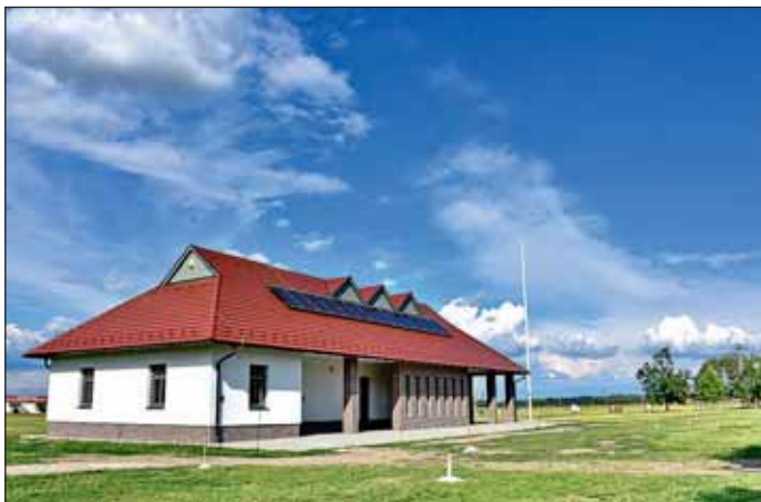
A vásártéri kiszolgáló épület és a Gál-kastélyig a kerékpárút is megépült
