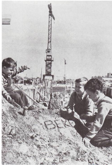
Játszó gyermekek az épülő városban
