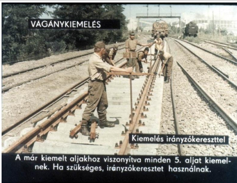
Feltehetőleg a Budapest-Vác-Szob vasútvonal 1967 és 1973 között zajló rekonstrukciójának egy jelenetét ábrázolja a felvétel, háttérben a Dunamenti Cementmű. 1970-ben, a vasútépítő katonáknak készített oktató dia.
