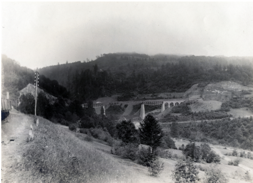
Az Uzsoki-völgy felrobbantott vasúti hídja 1915-ben. Forrás: Fortepan / Glatz Ödön
