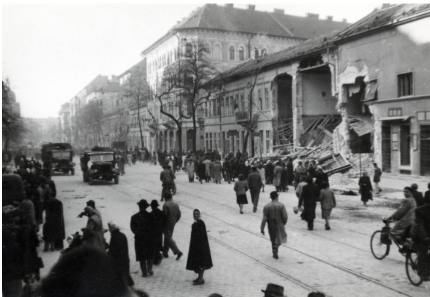
Az Üllői út 56. sz. épület a Vajdahunyad utca – Futó utca közötti szakaszon.
