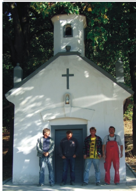
A felújított kápolna
