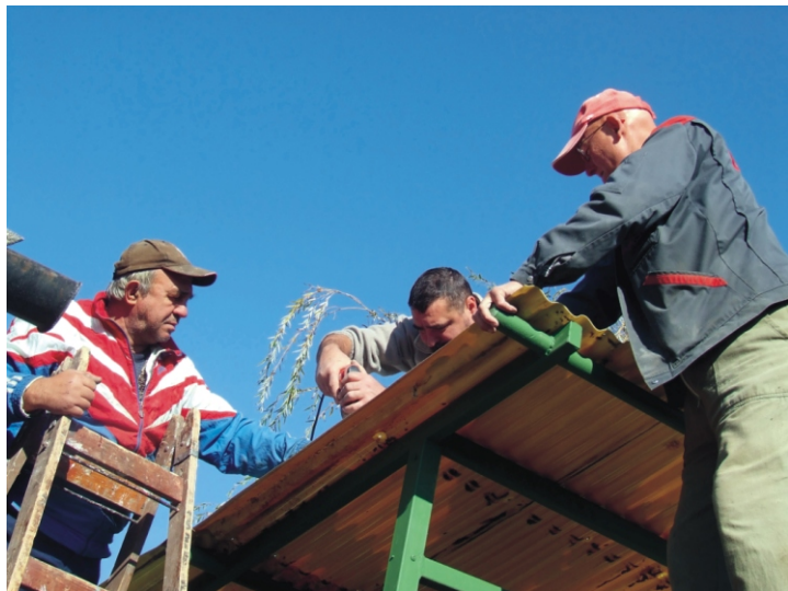
A tető rögzítése közben
