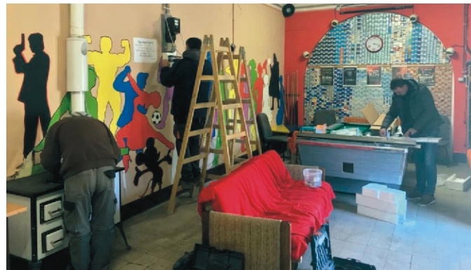
Zajlik az infrafűtés felszerelése
