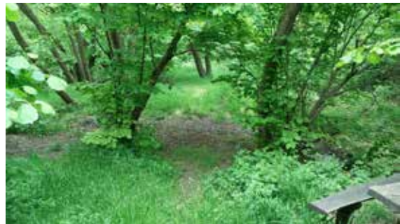
Hídi pihenőhely a felújítás előtt Forrás: Saját fotó, 2016. 05. 08. Hídi resting place before the renovation From: Own photo, 08/05/2016
