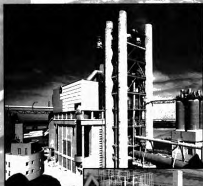
BEUMER nagyteljesítményű elevátorok a nyersliszt szállítására
