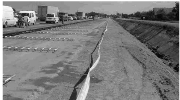
2. ábra Az előre elkészített hézagvasalás
