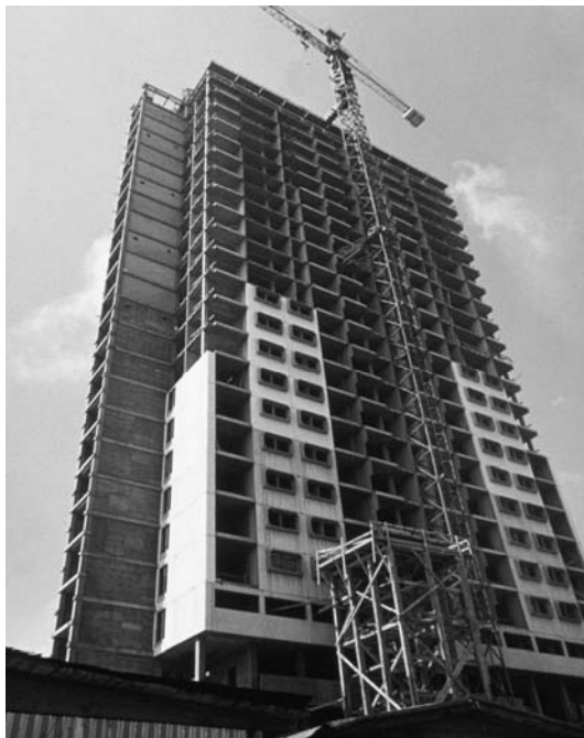
3. ábra A pécsi 25 emeletes „Magasház” szerelés közben
