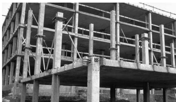
1a. és 1b. ábra A pillér-, födém- és szegélytartó elemekből álló vázszerkezet
