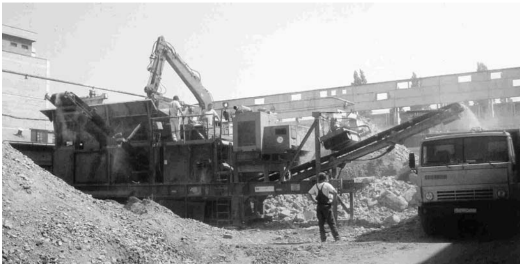
1. ábra A bontott építési törmelék előkészítése
