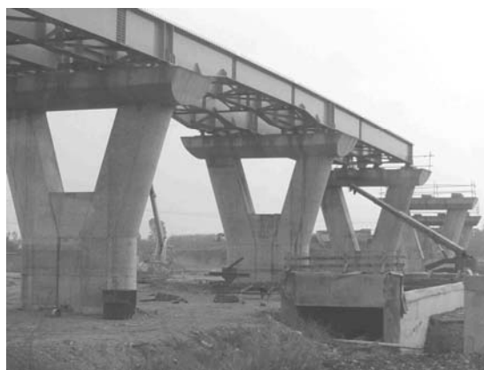
3. ábra Monolit híd építése
